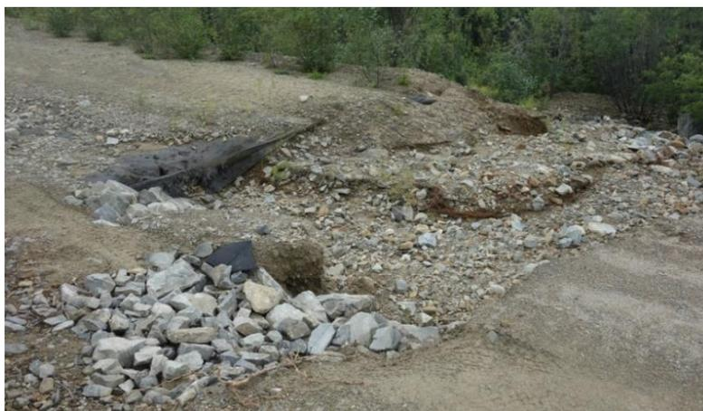
**Рисунок 1 – Размыв полотна дороги временными водотоками [фото автора]**
