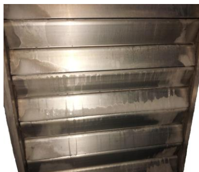
Рисунок 1 – Характерный внешний вид воздушного клапана заборного воздуха
